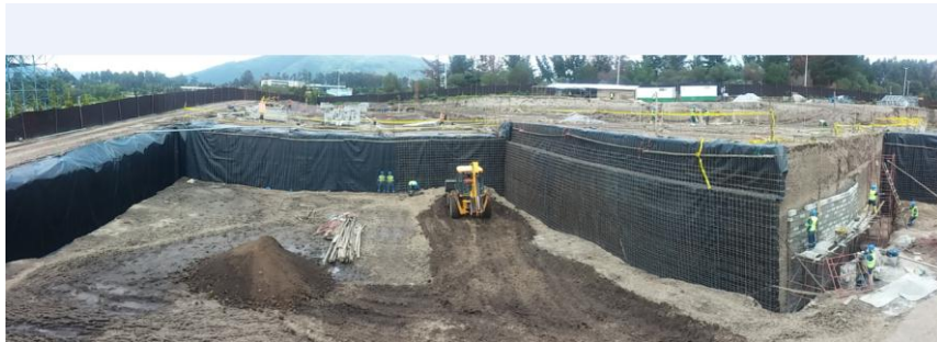
Bloque 6: Construcción de muros de subsuelo.
