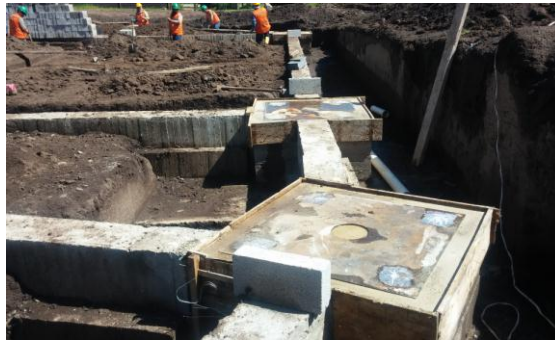
Bloque 8: Colocación de la palca metalica en todos los pedestales.
