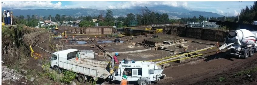
Bloque 1: Colocación de hormigón en cadenas de amarre.
