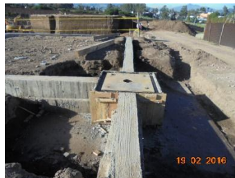
Figura 10 a) Armadura de cadenas que atraviesan el pedestal; b) Armadura para soportar la placa de apoyo; c) Placa de apoyo sobre pedestal.
