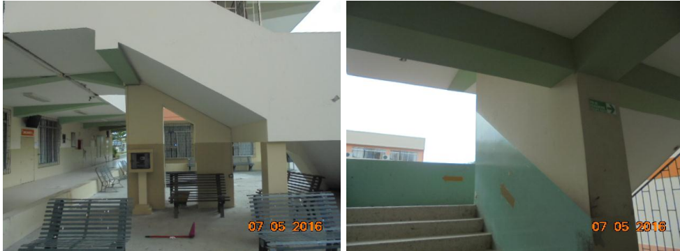
Figura 6 Columnas y vigas de la grada.
