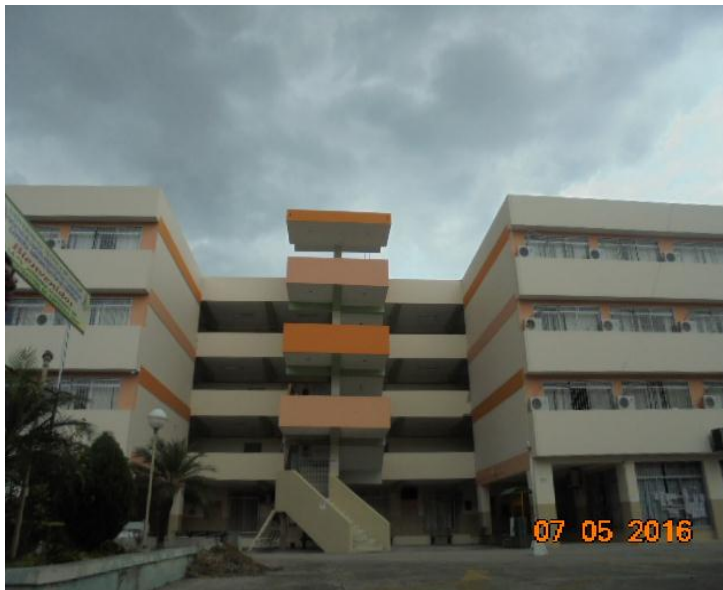
Figura 4 Edificio de la Carrera de Administración.
