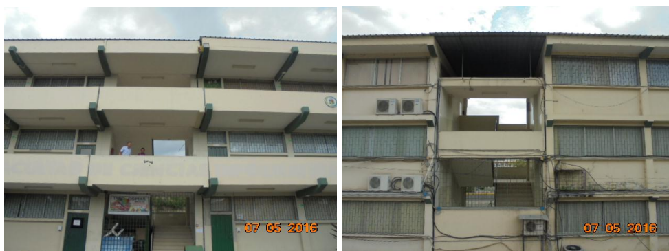
Figura 1 Mal comportamiento de las gradas de la Facultad de Informática de la Universidad Técnica de Manabí.
