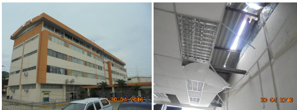
Figura 6 Estructura de acero de lámina delgada en último piso.
