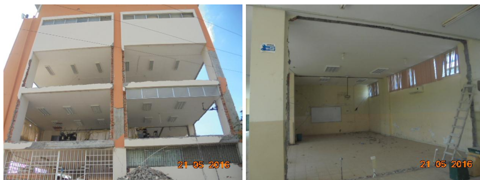
Figura 7 Derrocamiento de paredes para la reconstrucción.
