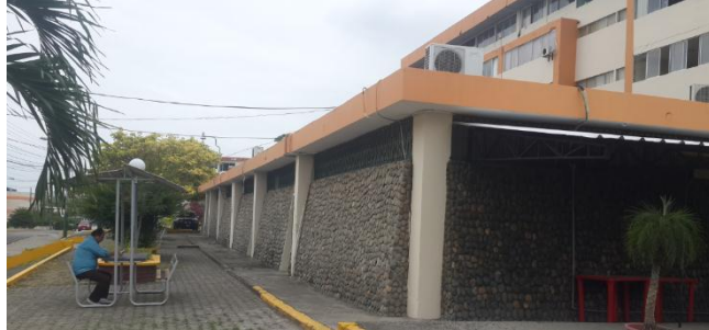
Figura 4 Columnas cortas de Bloques Estructurales 1, 2 y 3.
