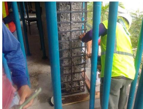
**Figura 10** Colocación de armadura vertical a 5 cm, de la cara del núcleo de columna y estribos individuales en cada una de las caras.
