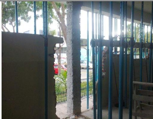
**Figura 9** Retirada de recubrimiento de las columnas.
