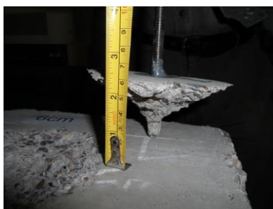
Figura 9: Falla del anclaje por arrancamiento del cono de hormigón.
