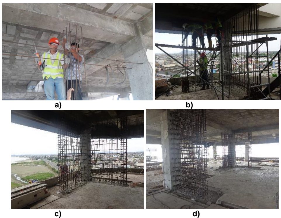
Figura 10 Armadura de la primera fase; a) Anclaje de refuerzo vertical a las vigas con aditivo químico; b) Armadura inferior anclado a viga inferior y armadura superior a viga superior; c) Armadura longitudinal inferior y superior sin armadura intermedia; d) Muro con Armadura Intermedia y anclaje de refuerzo horizontal.
