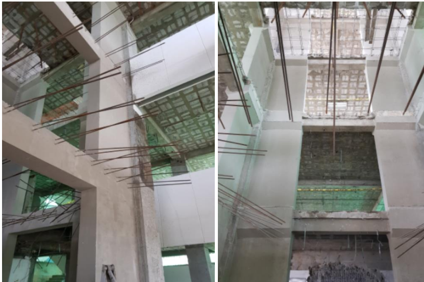
Figura 19 Abertura en la losa para paso de ascensor.
