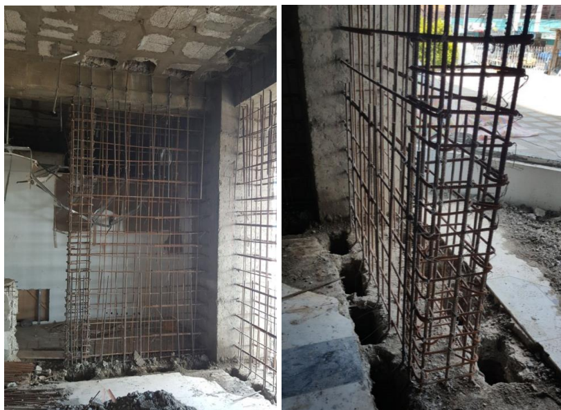
Figura 11 Armadura de continuidad del refuerzo vertical.
