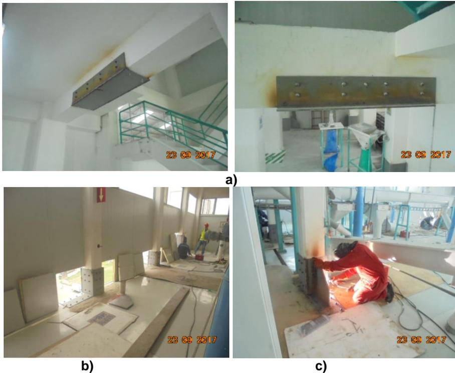
**Figura 17** Reforzamiento de Molinos Superior; a) Placa de acero en forma de "C" formada por tres piezas; b) Collarines del Contraviento; c) Placa Gusset inferior.
