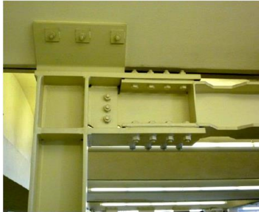
Figura 5. Detalle de una conexión viga-columna. Fuente: [10]
