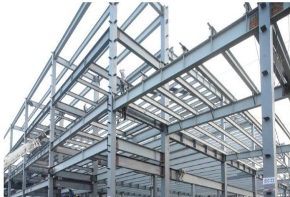
Figura 1. Estructura de Acero mediante conexiones apernadas. Fuente: [1]
