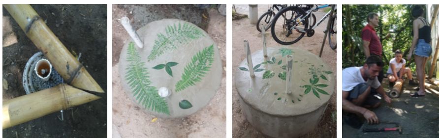
Figura 12. Detalles de la instalación de los tubos prefabricados cementantes.
