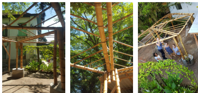
Figura 13. Imágenes de la estructura terminada.
