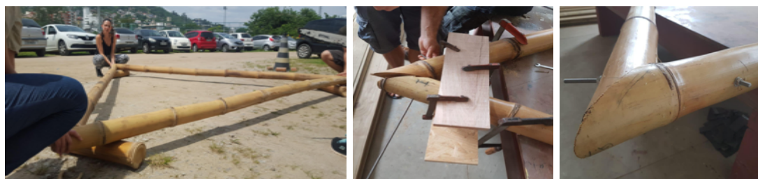
Figura 9. Prefabricación de los triángulos de vigas.
