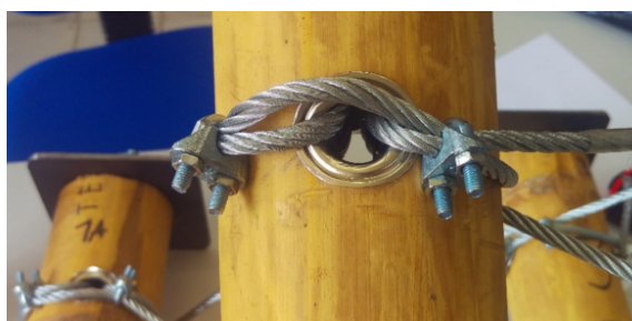
Figura 3. Acabado amarre nudo guadua.
