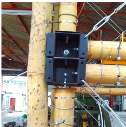
Figura 16. Verticalidad de estructura.
