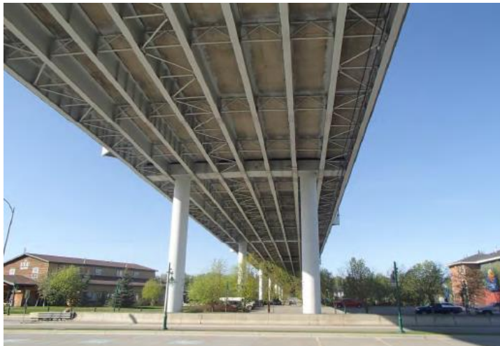
Figura 1: Puente Anchorage Port Access Fuente: (Calderón et al., 2018).
