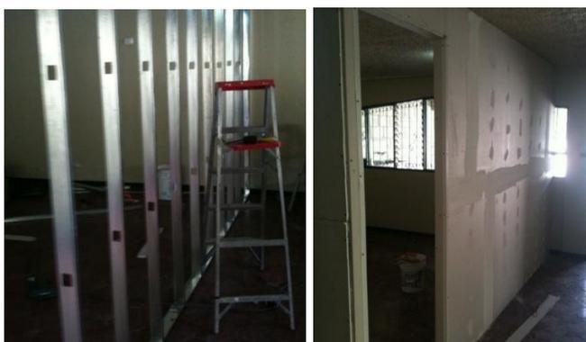
**Figura 6** Canales de Acero Galvanizado. **Figura 7** Acabado de la pared gypsum.
