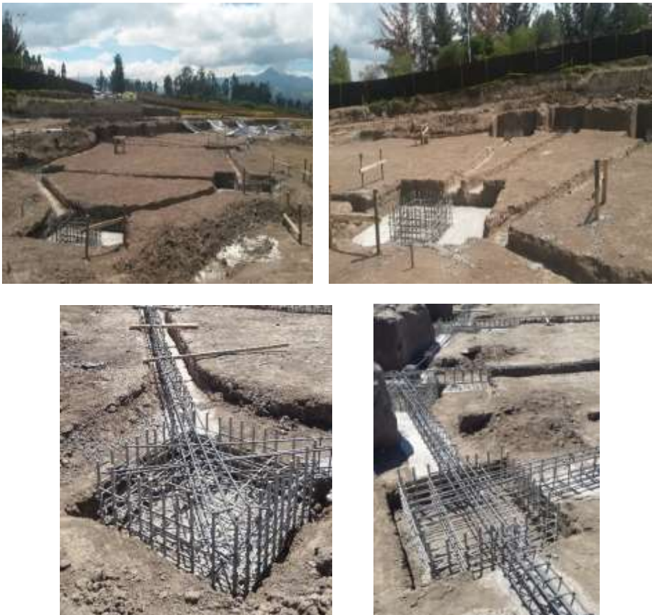
Figura 1 Panorámica del Bloque Estructural 8. (Fotografías tomadas en diciembre de 2015).
