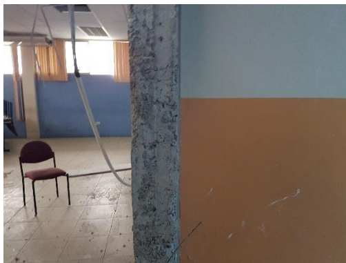
Figura 9 Columnas de hormigón armado (segunda planta alta)
