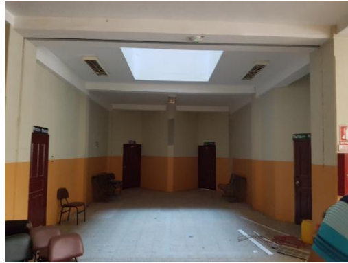
Figura 3 Bloque Estructural Tres de la Facultad de Administración
