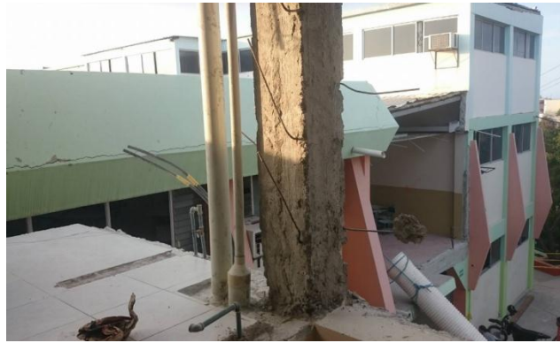
Figura 5 Tercera planta con las paredes retiradas
