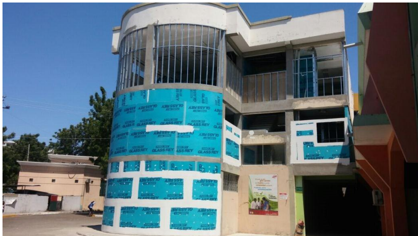
Figura 17 Fachada principal de la Facultad de Economía
