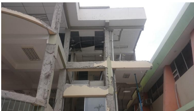
Figura 3 Estructura con la mampostería retirada.
