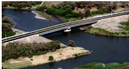
Figura 4 Puente Norte Fuente: Guaygua (2015)
