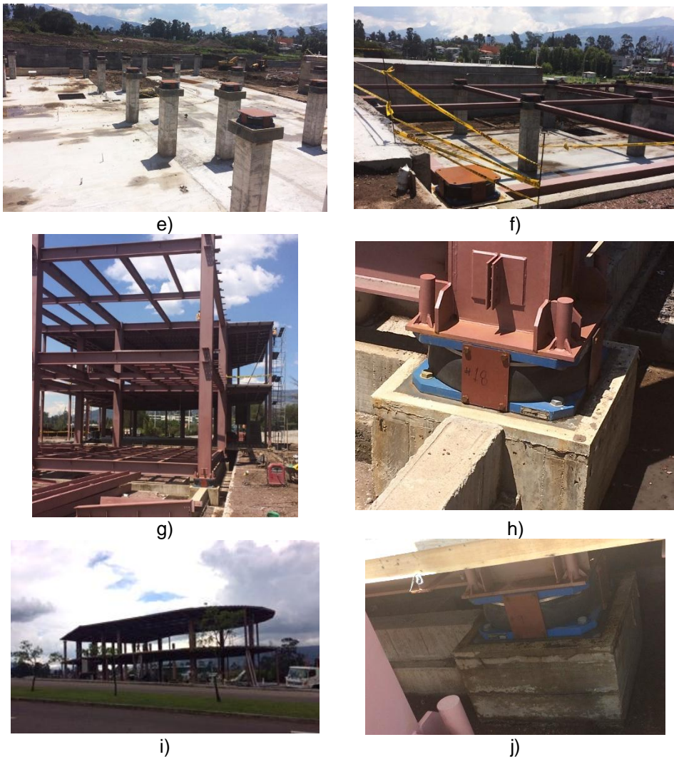
Figura 8 Centro de Investigaciones y Posgrado UFA–ESPE; a) Perspectiva Noreste; b) Ubicación de los bloques estructurales; Fotografías de la etapa constructiva hasta octubre del 2016 c) Bloque 1; d) Aislador del Bloque 1; e) Colocación de aisladores en el Bloque 2; f) Colocación de aisladores en el Bloque 6; g) Bloque 7; h) Aislador Bloque 7; i) Bloque 8; j) Aislador Bloque 8.
