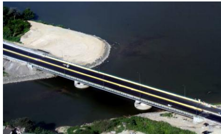
Figura 3 Puente Sur Fuente: Guaygua (2015)
