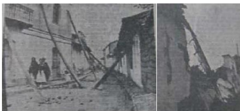
Figura 1 Daños ocasionados en el valle por efecto del sismo de 1938. Barona (2010).
