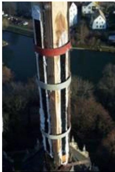
Figura 3 Reforzamiento torre Catedral de Merseburg.
