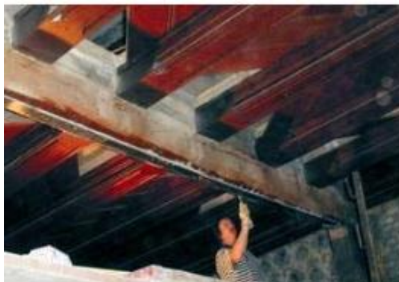
Figura 1 Reforzamiento del Castillo Mansfeld.
