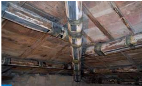
Figura 2 Reforzamiento del Palacio Farnecio.
