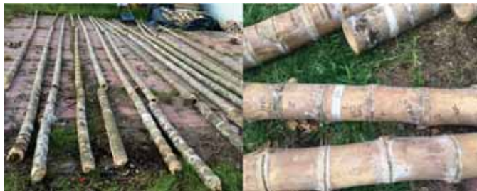
Figura 3. Acopio, marcación de entrenudos.
