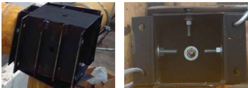
Figura 8. Fotografía nudo metálico.
