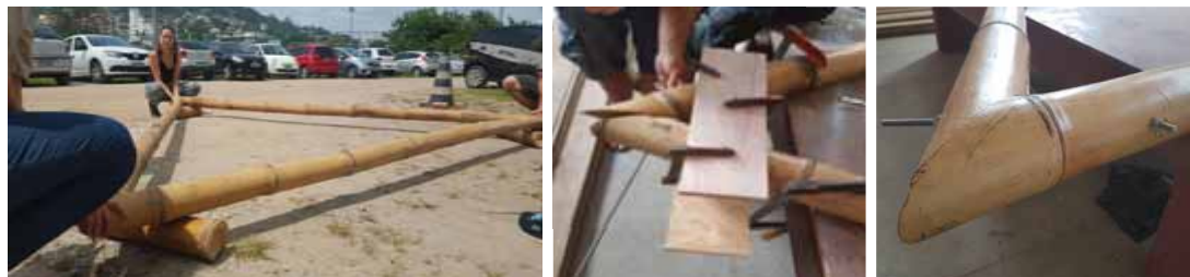
Figura 9. Prefabricación de los triángulos de vigas.
