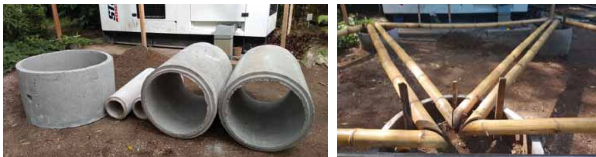
Figura 11. Tubos de cemento para fundición (arriba) y demarcación con la ayuda de los módulos (abajo).
