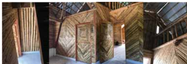
Figura 18. Acabados muros interiores, reglilla con barniz.
