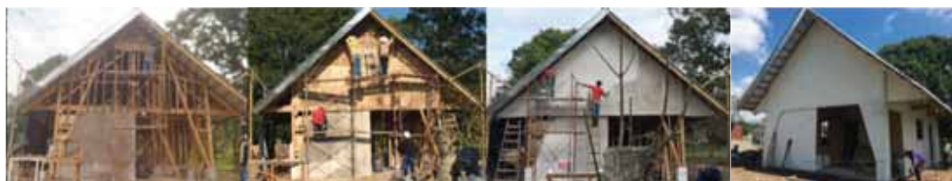
Figura 17. Estructura de muros, recubrimiento con esterilla y aplanado.
