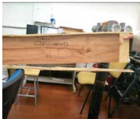
Figura 14. Separación de la guadua del patin inferior en un extremo de la viga.
