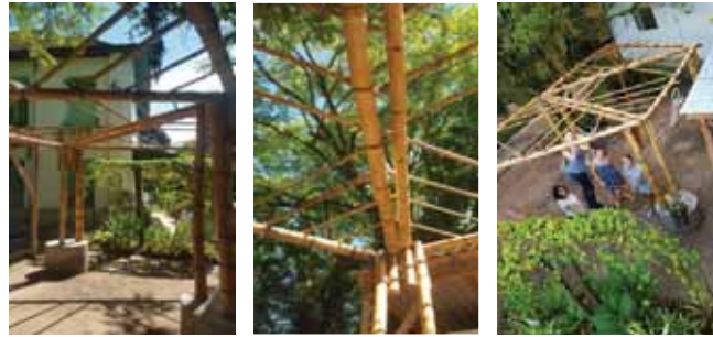
Figura 13. Imágenes de la estructura terminada.
