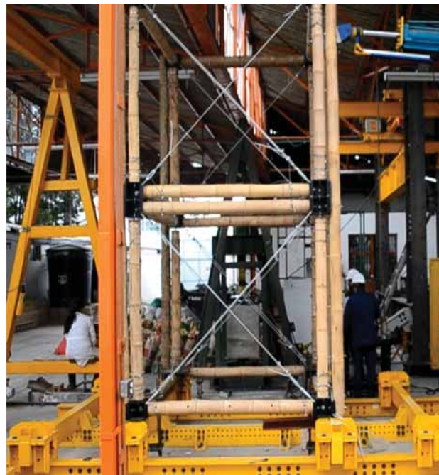
Figura 20. Fotografía del módulo después del fallo.
